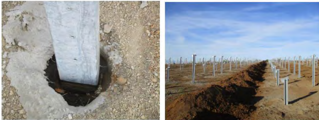
Exemple de fondation type pieux
