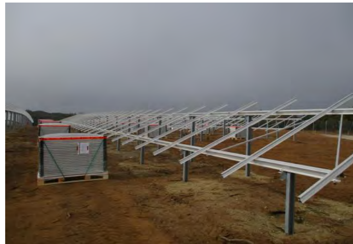
Figure 31 : Assemblage des structures sur site (Source : RES)
