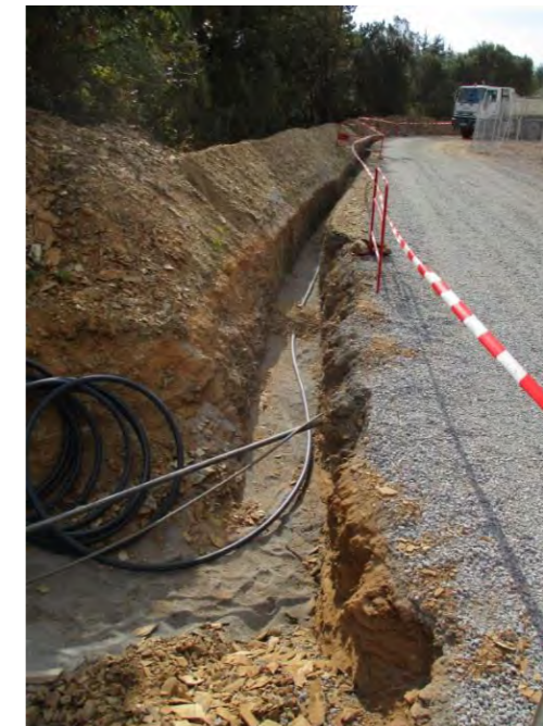
Figure 33 : Exemple de tranchée en bordure de piste (Source : RES)
